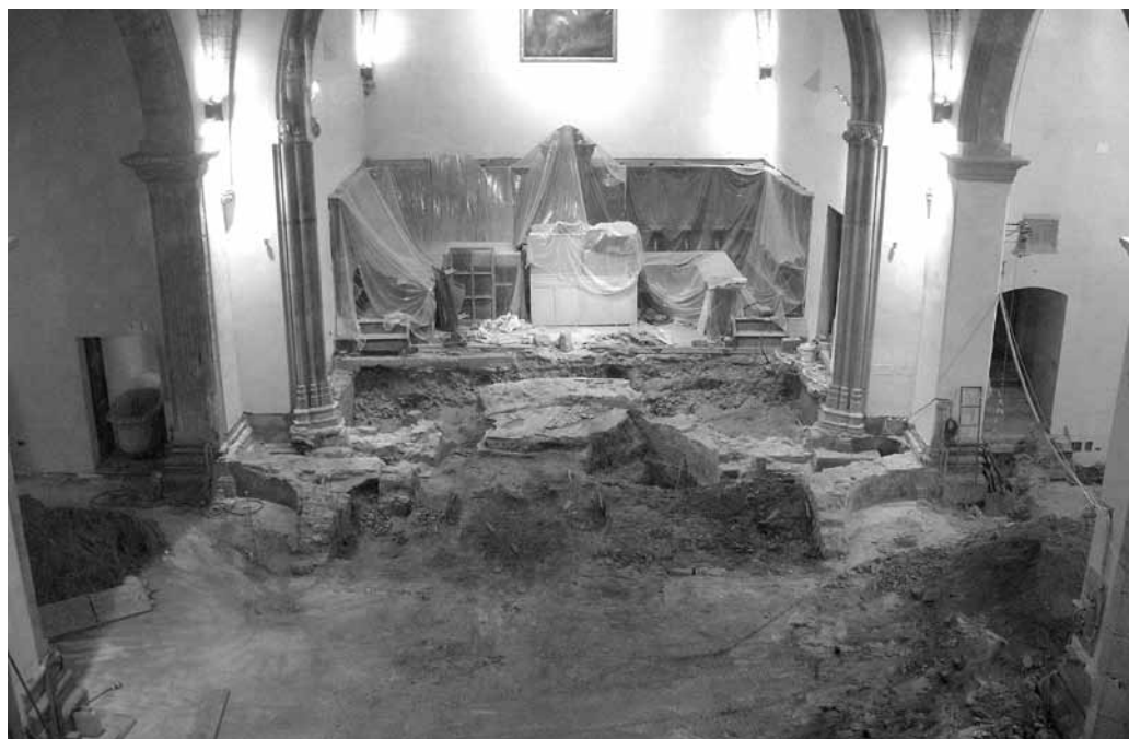
IGLESIAS - Santa Chiara . 1) Situazione all'inizio dei lavori con l'imboccatura della cripta al centro (foto U. Viridis); 2) L'abside duecentesca e le strutture posteriori emerse nel presbiterio (foto A. L. Sanna)
